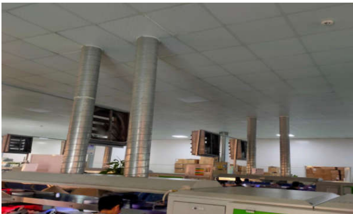
Bảng 4.3. Thông số kỹ thuật của hệ thống xử lý hơi dung môi
