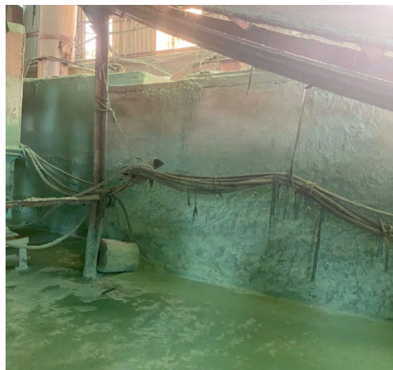
Hình ảnh bể đập bụi
