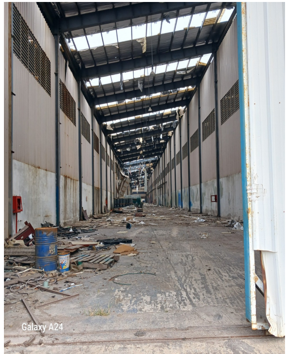
Bên trong nhà xưởng
