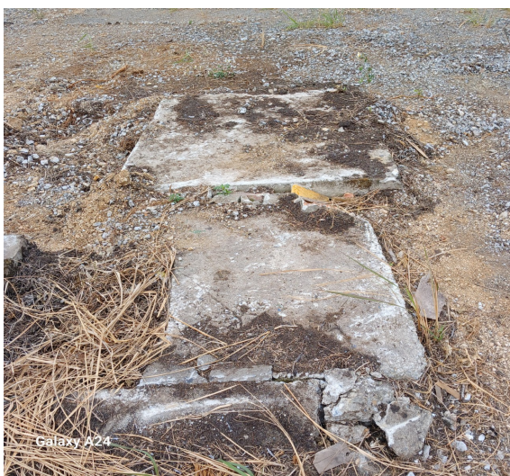
Hố ga thu gom nước thải
