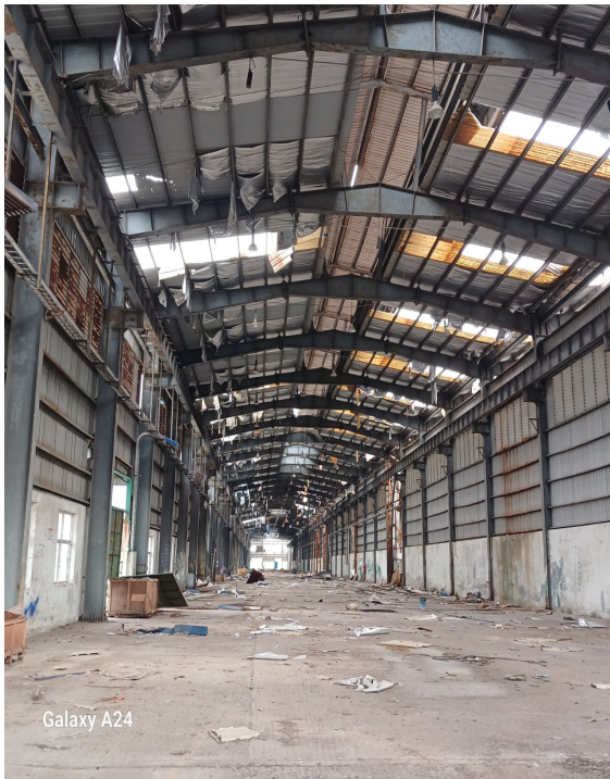
Bên trong nhà xưởng
