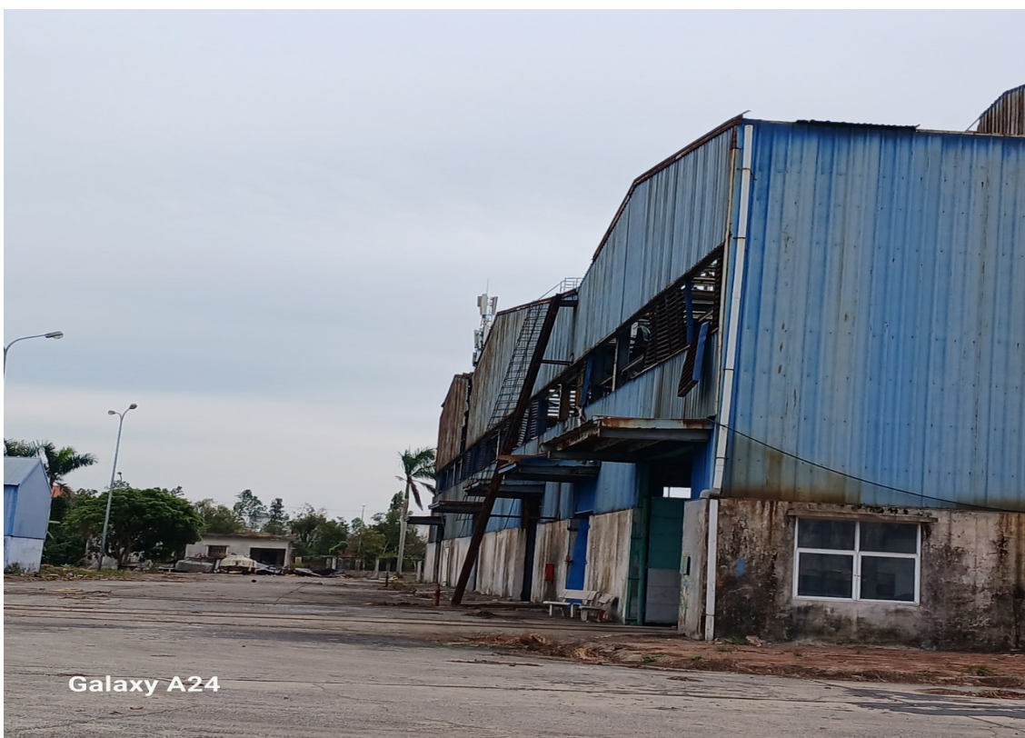
Phía bên ngoài khu vực nhà xưởng
