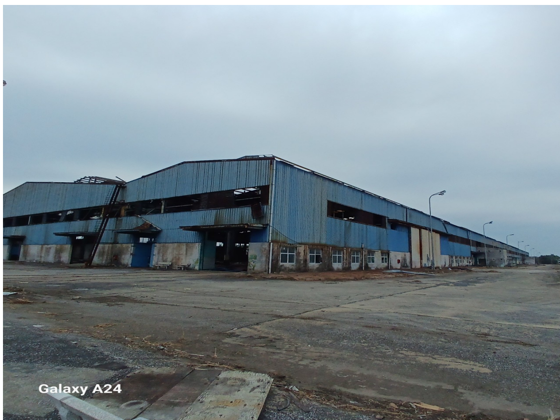
Phía bên ngoài khu vực nhà xưởng
